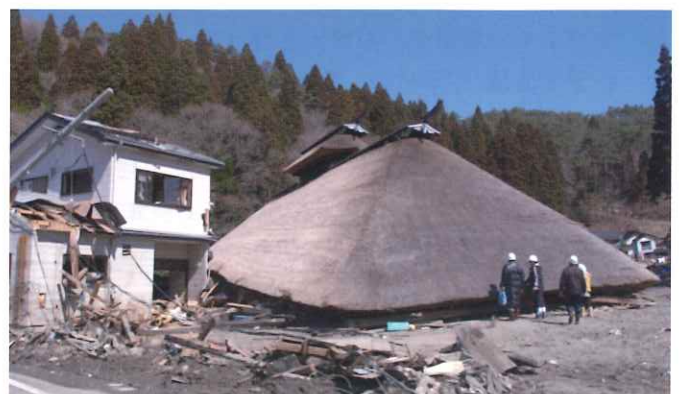
震災後、屋根だけが残った尾形家住宅
